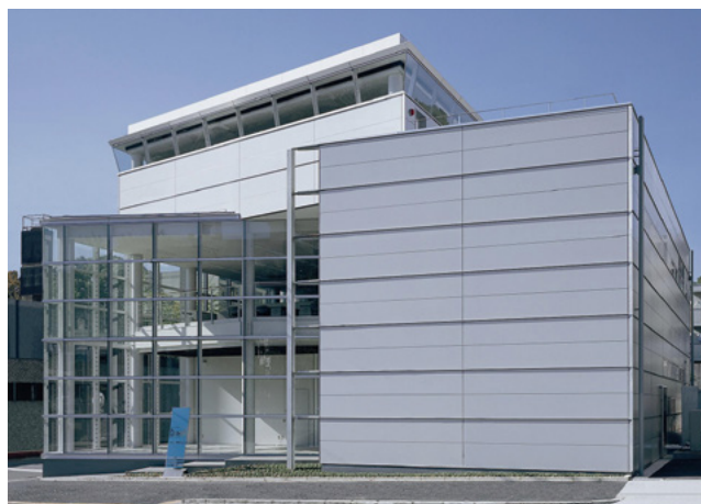
建物名：ダイヘン中部支社 設 計：竹中工務店 所在地：名古屋市千種区 施 工：竹中工務店
