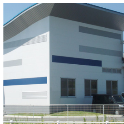
横張り工法ランダム使いの例
